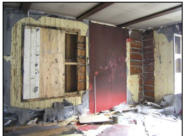
Bilde U Innkledd vindu og loft hjørne SYDØST 2. etasje.
