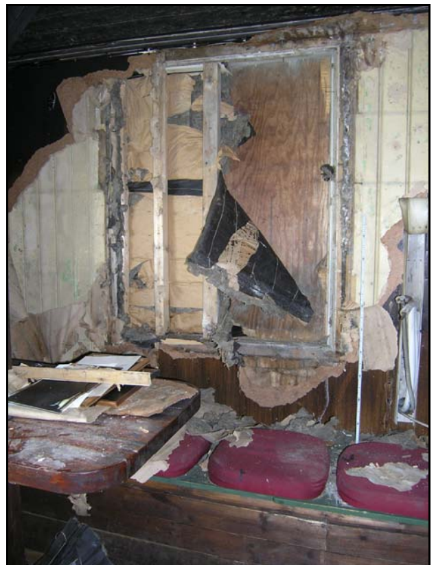
Bilde Q Innkledd vindu 1. etasje.
