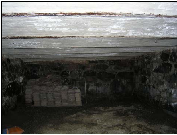
Bilde M Kjellerrom 2.
