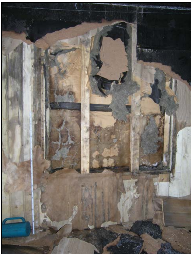
Bilde O Innkledd vindu 1. etasje.
