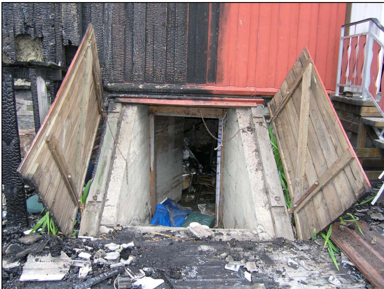
Bilde G Nedgang til Kjeller.
