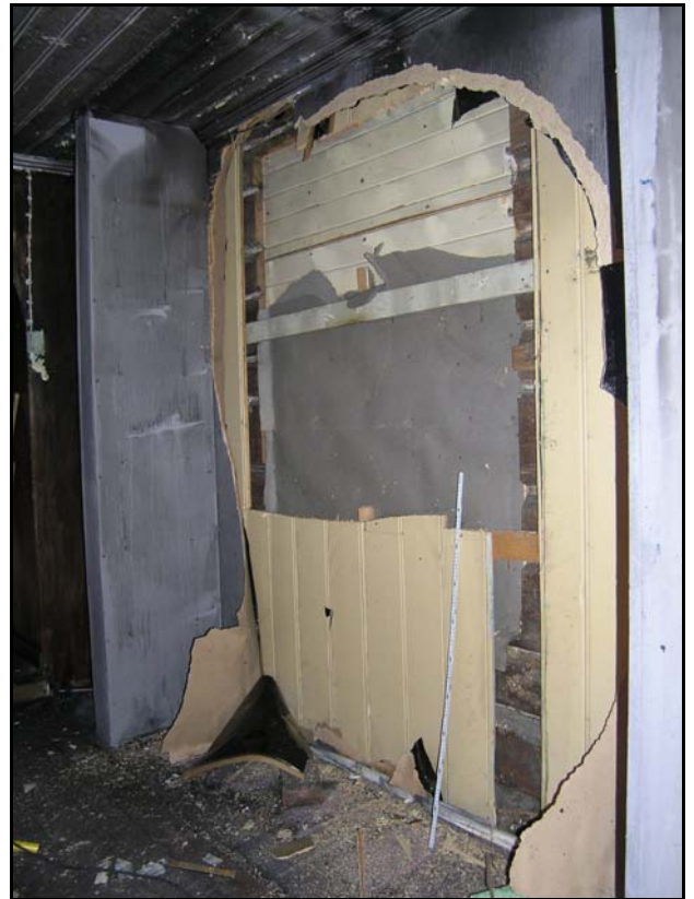
Bilde P Innkledd vindu 1. etasje.
