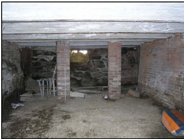
Bilde N Kjellerrom 2.
