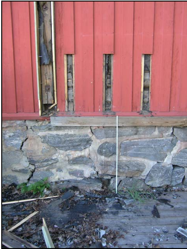
Bilde H Utveksling i nov og tømmer mot VEST.
