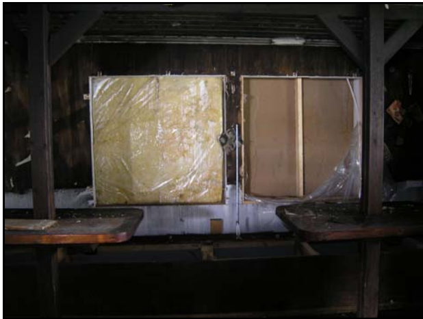
Bilde R Innkledd vindu 1. etasje.
